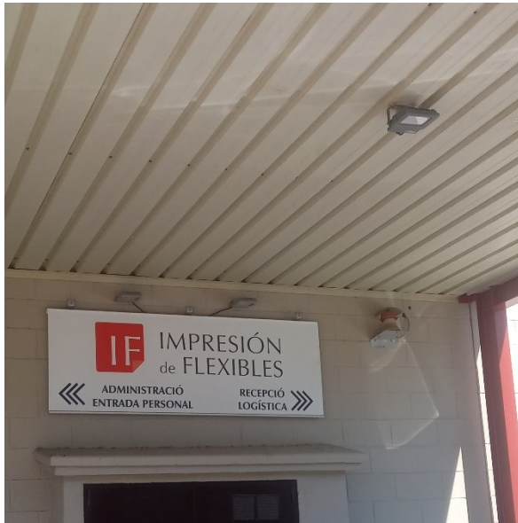
Imatge 1. L·luminàries ENERGY TECH 20W 730 90 IP65 GRIS 7010 emprades per la il·luminació dels cartells.
