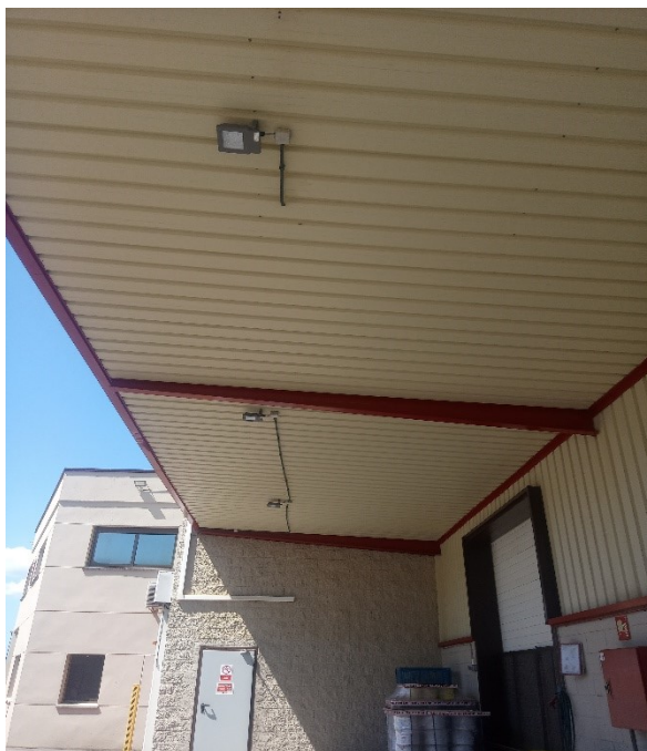
Imatge 3. L·luminàries ENERGY TECH 40W 730 90° IP65 GRIS 7010 emprades sota cobert.
