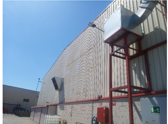
Imatge 2. L·luminàries ENERGY TECH 120W 730 90 IP65 GRIS 7010 emprades en el perímetre exterior.
