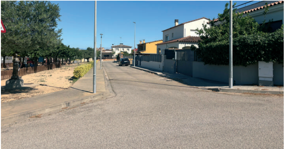
Vista del barri de les Eres, una de les zones que encara no té canalització específica
