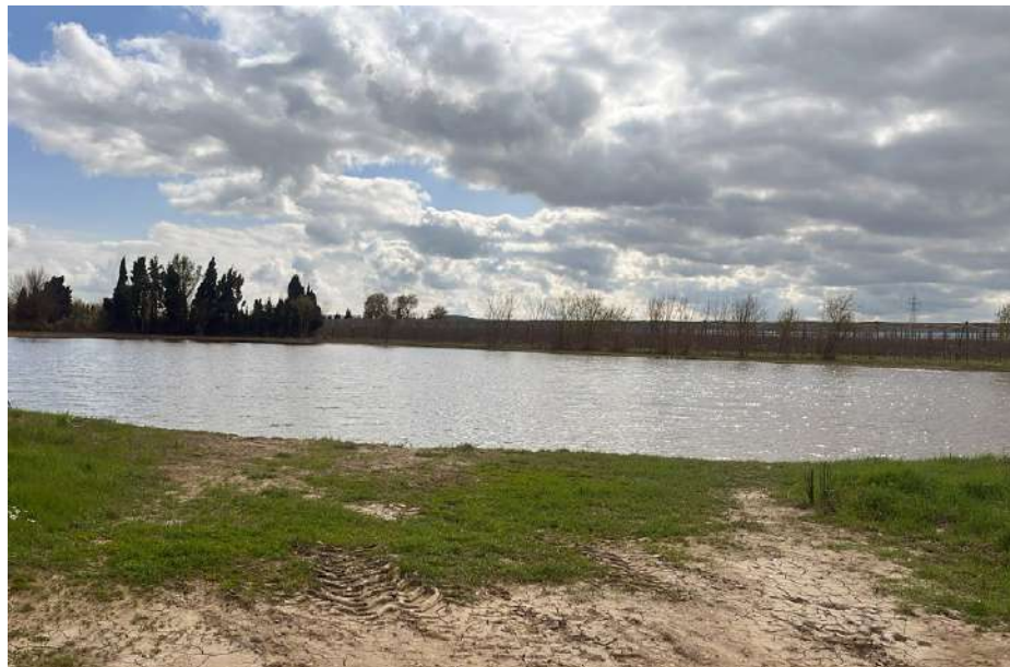
Aspecte d'una de les quatre basses de laminació que s'han construït
