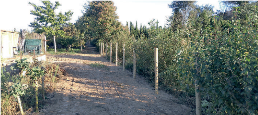
Treballs de rehabilitació de talussos i instal·lació de la tanca texana a la zona de pas dels horts. Imatge del passat mes de març. Font: Arxiu HidroNet Baix Ter
