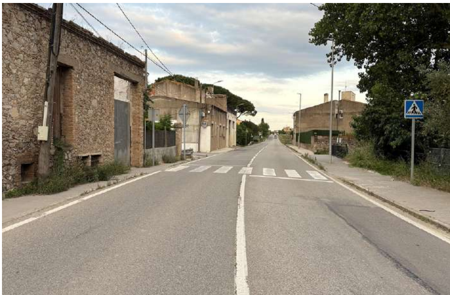
Aspecte d'un tram de la carretera on s'actuarà
