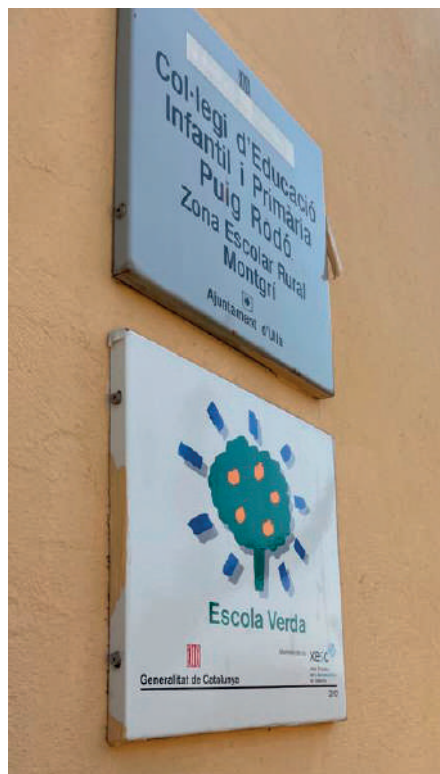
Façana de l'edifici de l'Escola Puig Rodó
