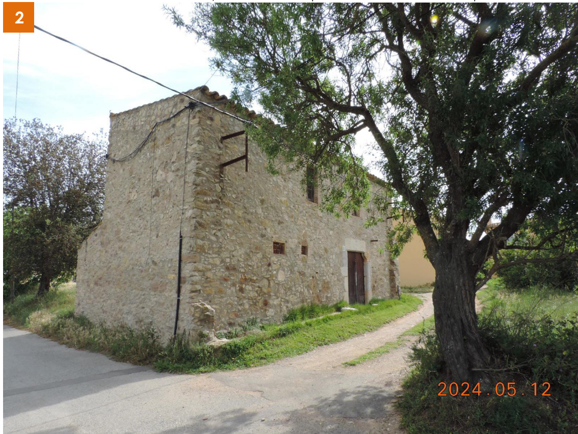
Foto 6. Accés a l'àmbit del PAE, on es visualitzen peus d'arbres i la construcció preexistent.
