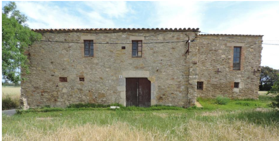
Foto 12. Construcció preexistent, façana nord i est.
