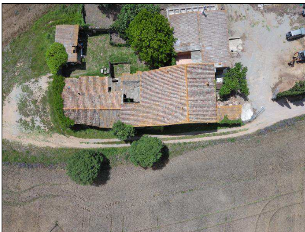
9. Vista zenital del Mas Caner. Les noves edificacions s'han anat articulant entorn del cos original de la Masia.
