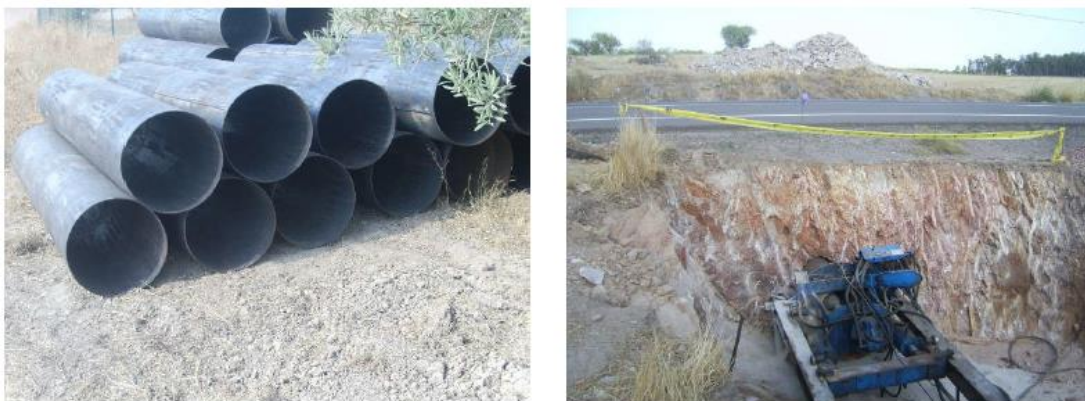
Imatge 1. Vaines metàl·liques i fossat d'atac i perforació.
