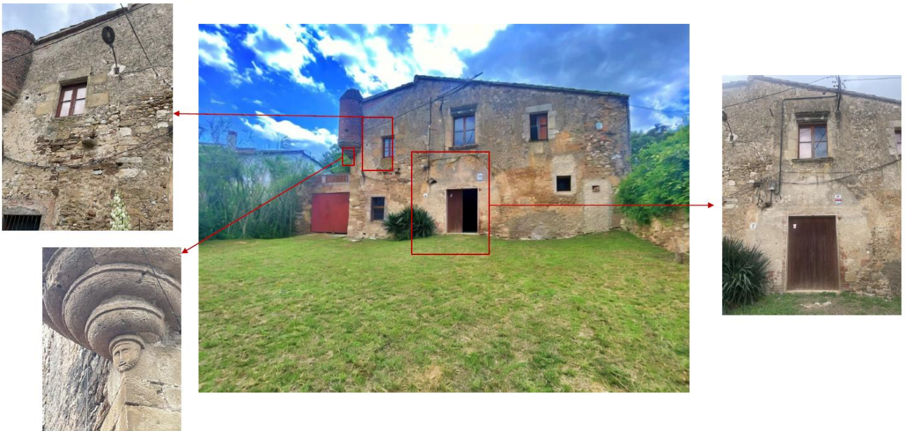
Façana exterior – Estat Actual Est
