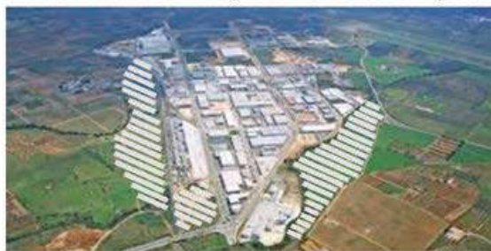
ENVOLTAT DE PLAQUES FOTOVOLTAIQUES
