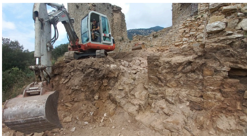
Vista del procés d'excavació de l'enderroc del sector 5.
