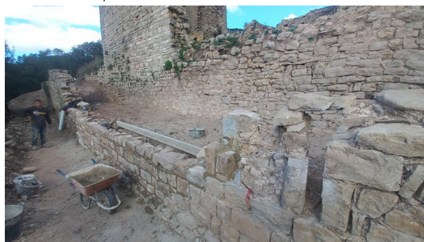
Vista del procés de consolidació d'un dels murs del sector 5
