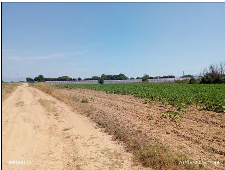
Foto 1. Instal·lació fotovoltaica a l'entorn del camí de la Ribera.
