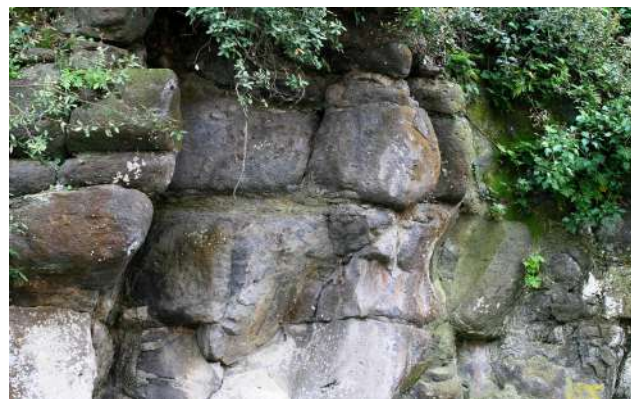
SALVADOR SARQUELLA FOTOGRAFIA 11. Colada al veïnat del Torn
