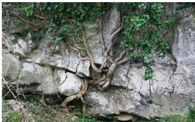
SALVADOR SARQUELLA FOTOGRAFIA 10. Colada al veïnat del Torn
