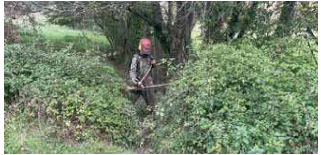
Treball de desbroçada d'esbarzers i abans dels moviments de terra per obrir pas entre marges a diferents nivell
