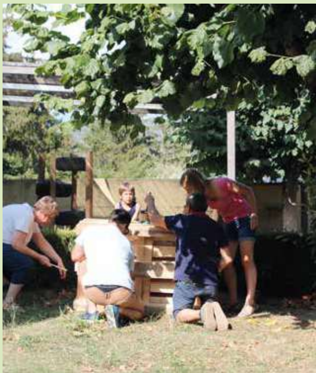
Construcció del banc per les famílies de l'espai taronja. Estiu 2023
