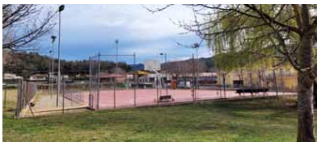
Pista poliesportiva abans de les obres
