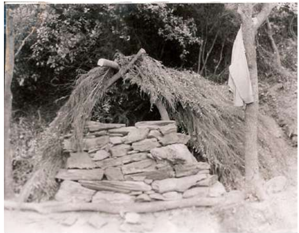
Barraca de carboners en construcció. Foto Josep Cortina.
