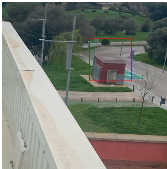
Figura 13. Escomesa existent al Centre Cívic Regencós vist des de la coberta. Font: elaboració pròpia.
