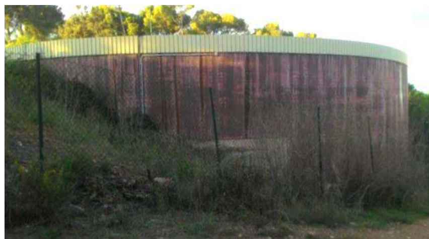
Figura 4 - Exterior del dipòsit de Quermany.
