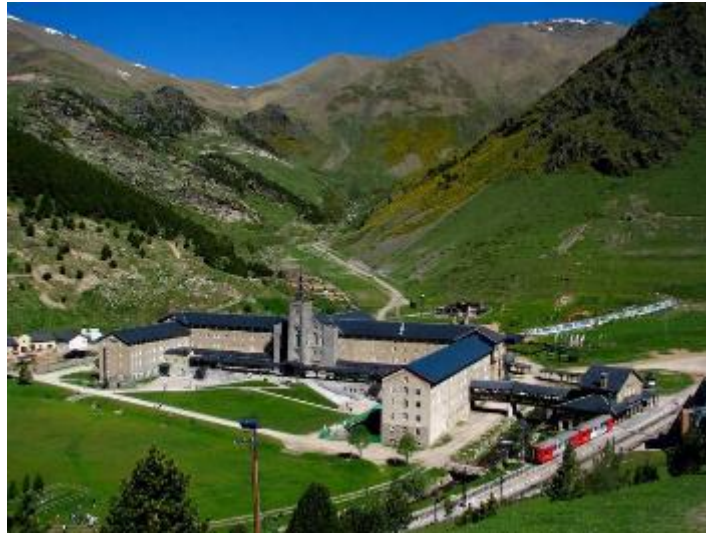
Vista general del santuari dels edificis auxiliars
