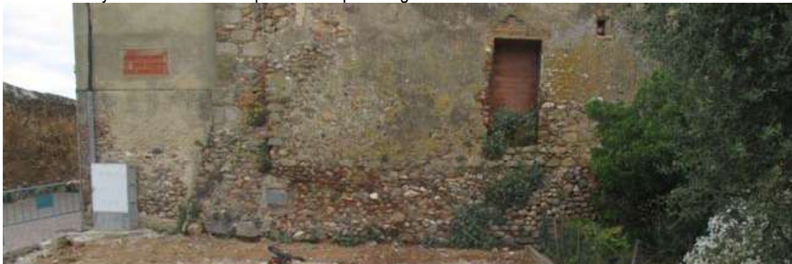
Vista de la façana de planta baixa l'any 2019 un cop enderrocat el dipòsit municipal i abans de l'adequació de la placeta
