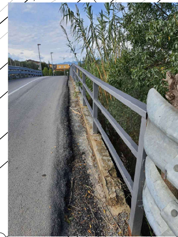
BARANA TUBULAR FORMADA PER TRAVESSERS DE 100x50 50x50 I SOBRE DE 70x80
