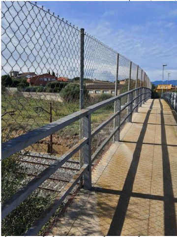
BARANA TUBULAR FORMADA PER TRAVESSERS DE 100x50 50x50 I SOBRE DE 70x80 TANCA DE SIMPLE TORSIÓ DE 1,90 cm D'ALÇADA
