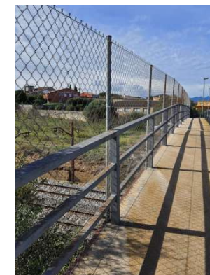
Figura 2. Proteccions existents marge zona de vianants
