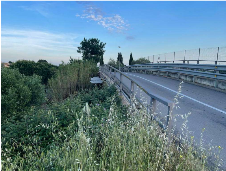
Figura 1. Baranes i proteccions existents
