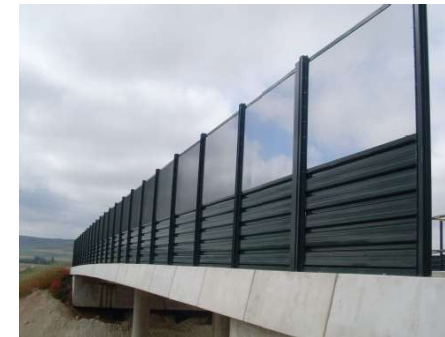
Figura 3. Tanca de protecció antivandàlica ADIF
