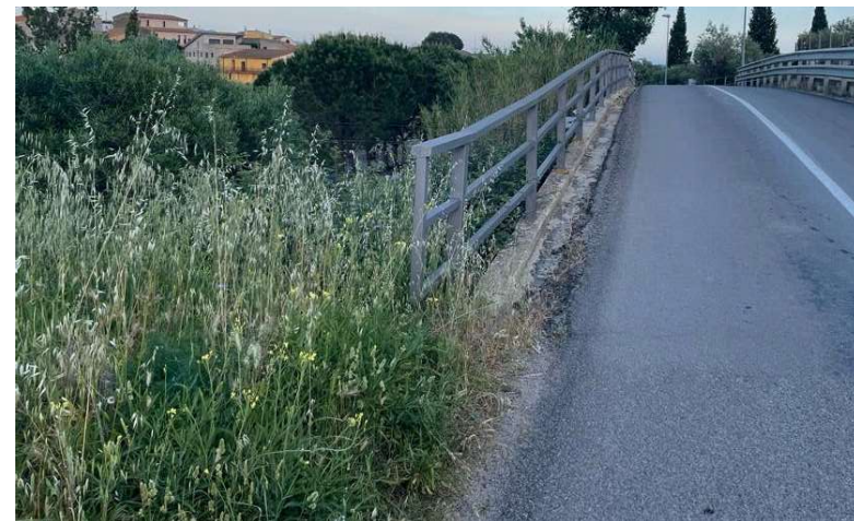
Figura 3. Barana tubular sobre vorada de formigó
