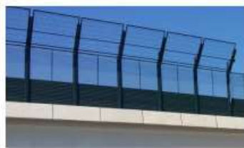
Figura 9. Cerramiento de protección antivandálica con detector de caída de objetos.
