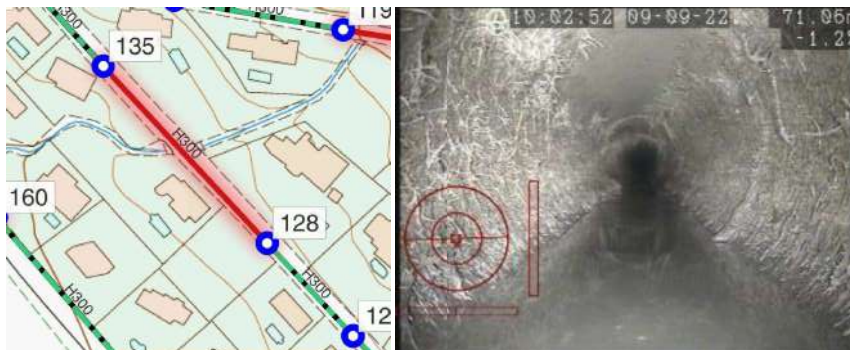
Figura 11. Localització ingerència (esquerra) i canonada amb arrels a les juntes (dreta).
