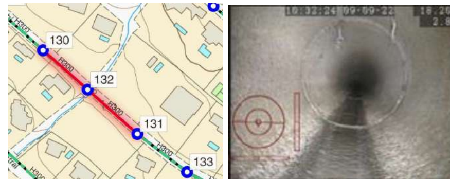
Figura 13. Localització ingerència (esquerra) i canonada amb arrels a les juntes (dreta).
