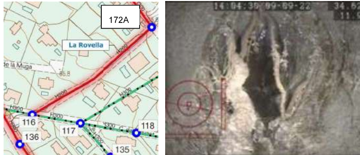
Figura 7. Localització tercera ingerència (esquerra) i canonada amb presència d'arrels (dreta).
