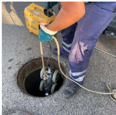
Figura 10. Inspecció col·lector amb càmera.
