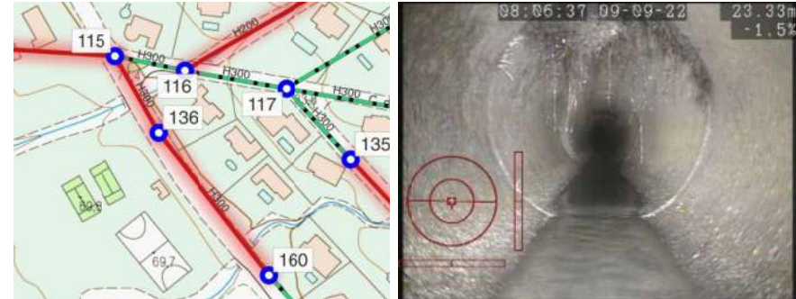
Figura 9. Localització ingerència (esquerra) i canonada amb arrels a les juntes (dreta).
