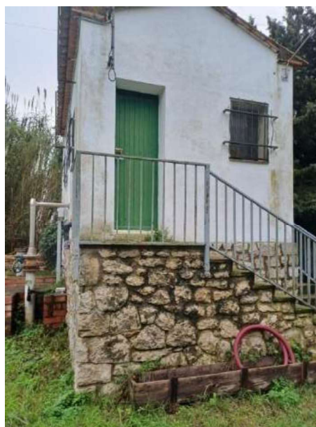
Fotografia 16. Exterior caseta i antics calderons
