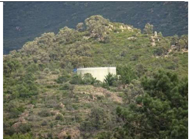
Fotografia 35. Vista general del dipòsit
