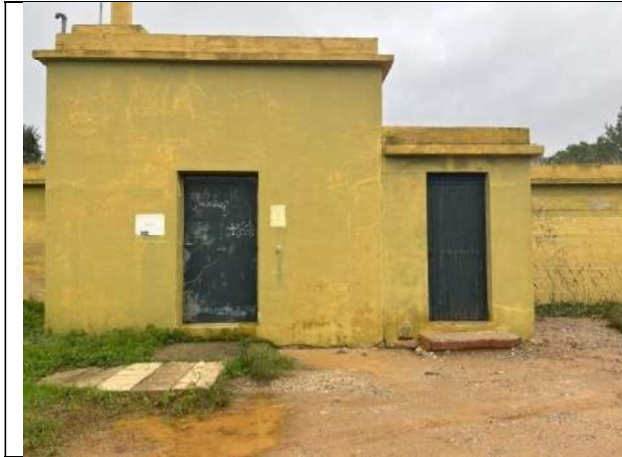
Fotografia 17. Vista general del dipòsit
