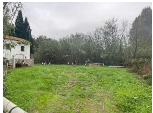
Fotografia 2. Vista general de la instal·lació
