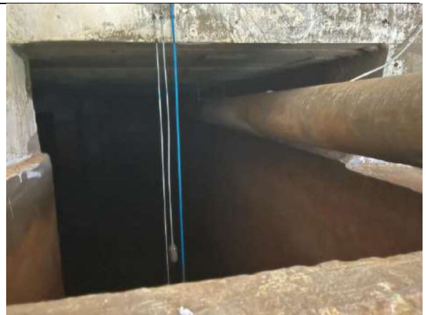
Fotografia 24. Interior dels vasos del dipòsit
