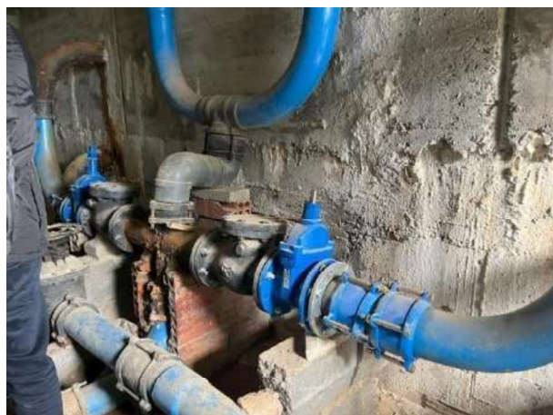
Fotografia 55. Caldereria conduccions entrada i sortida
