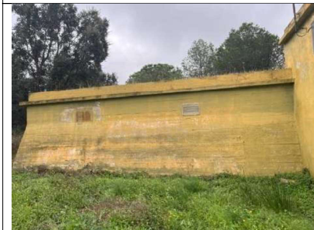
Fotografia 19. Ventilacions laterals del dipòsit
