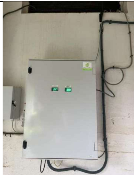
Fotografia 26. Remota de control. Visor nivells
