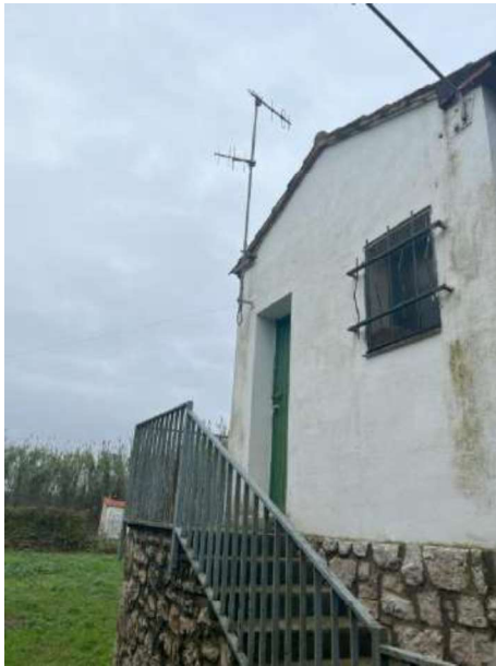
Fotografia 9. Vista exterior caseta de control
