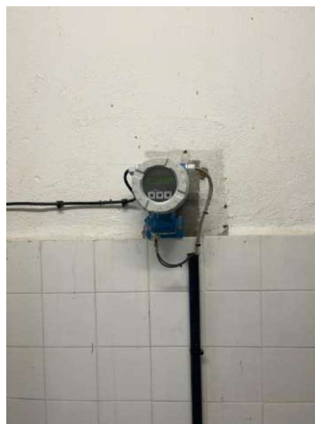
Fotografia 8. Display cabalímetre
