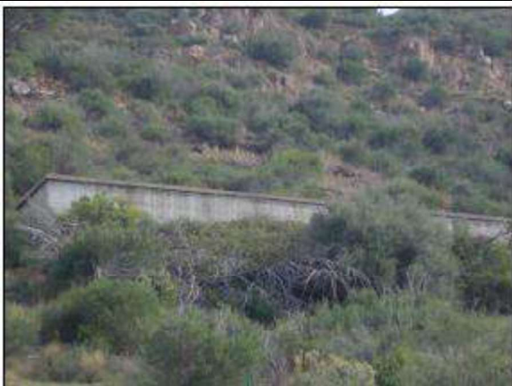
Fotografia 44. Vista general del dipòsit
