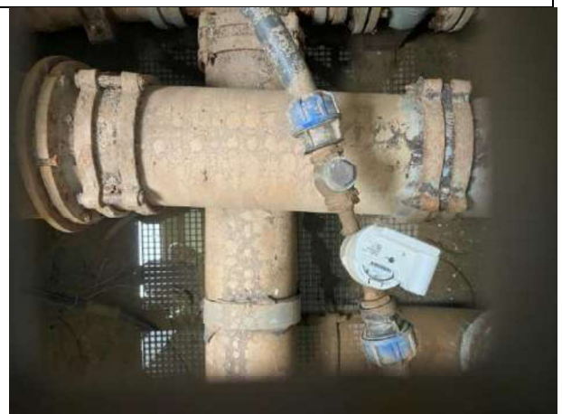
Fotografia 22. Arribada aigua al dipòsit
