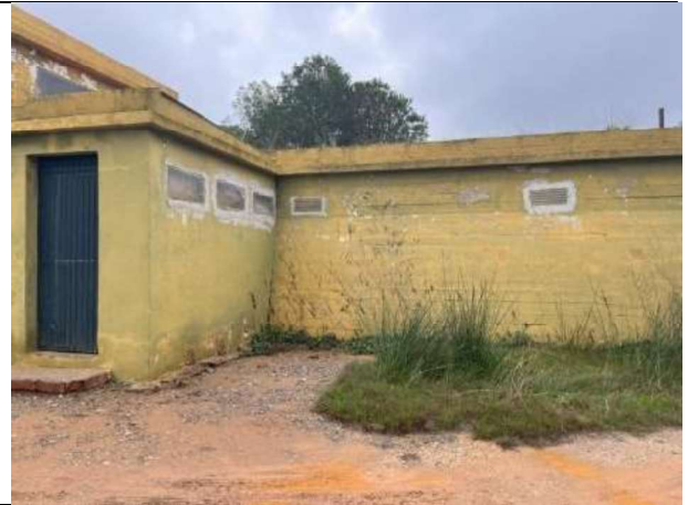
Fotografia 18. Ventilacions laterals del dipòsit
