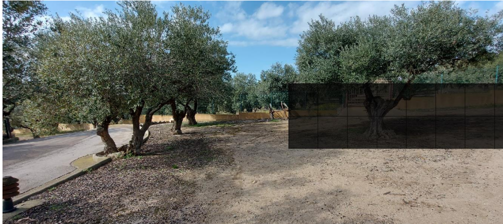
Figura 18. Fotografia 1. Gràcies els altres habitatges, des d'aquest lateral la instal·lació queda totalment amagada.
