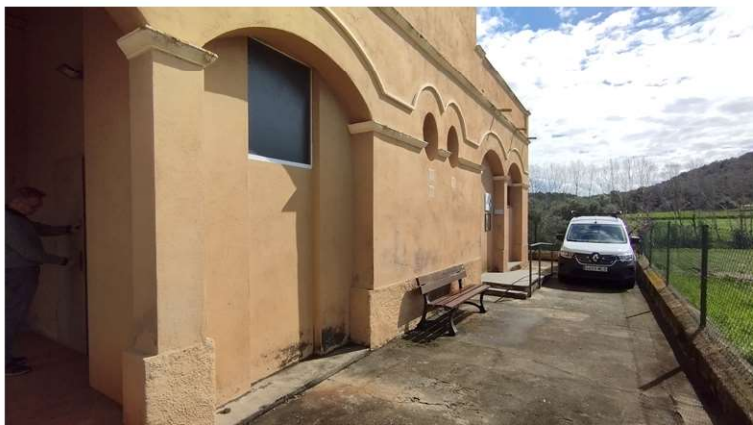
11 Exterior sala Instal·lacions.jpg
