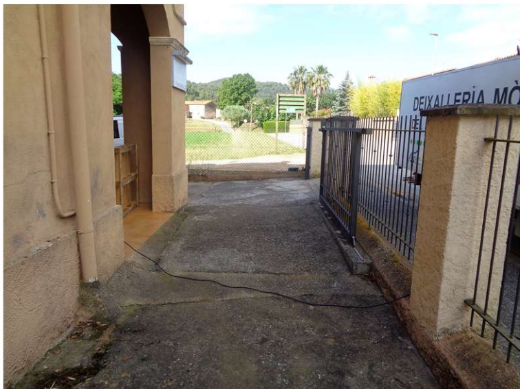
19 Reixes tanca perimetral.JPG
