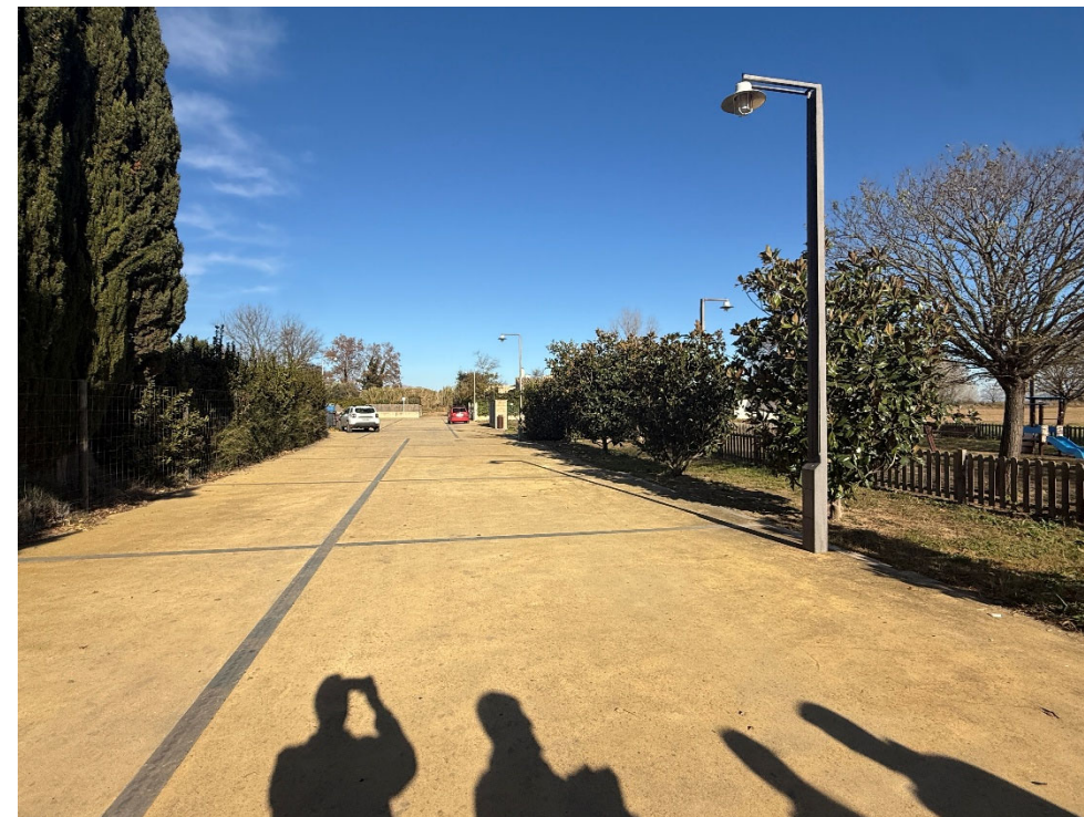
Figura 9. Carrer del Clos, paviment amb formigó
