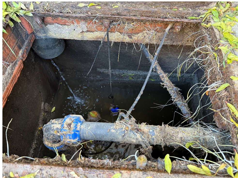
Figura 3. Arqueta del bombament existent a anul·lar.
