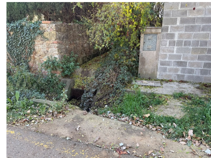
Figura 2. Bombament existent arqueta de registre al C/Major
