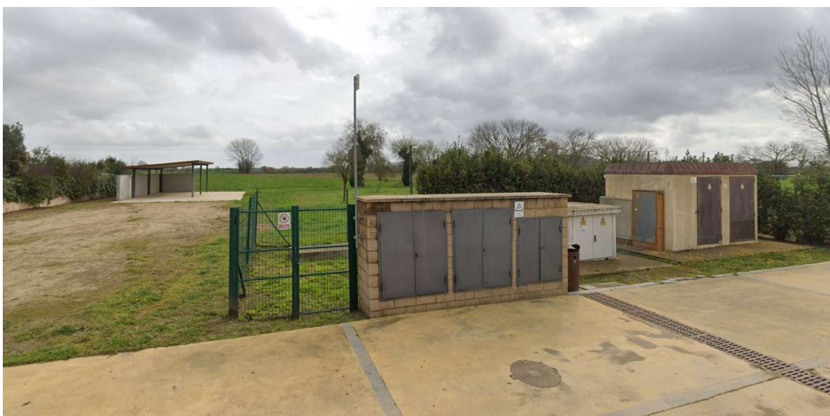
EBAR i centres de transformació en el front vial, a l'esquerra al fons cobert
