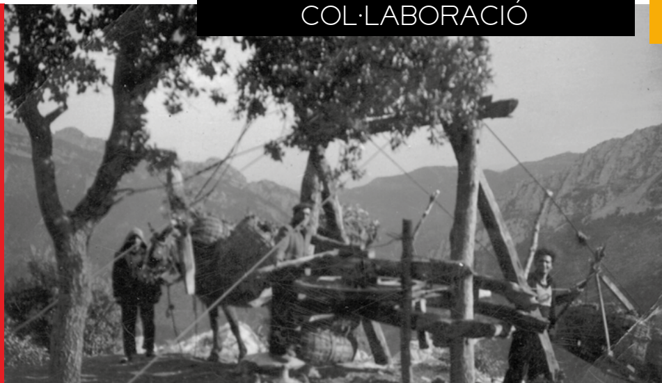
Cable instal·lat als cingles d'Ortmoier d'Oix per baixar sarrions de carbó. Anys 1950. Arxiu família Mayà d'Oix
