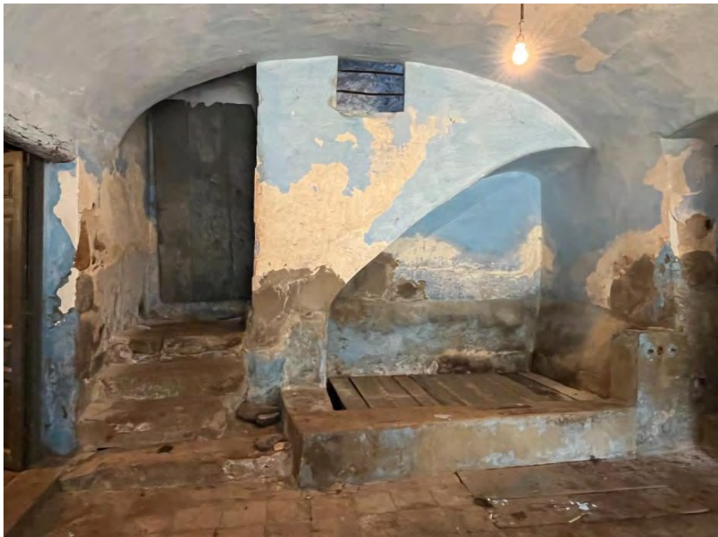
Escala accés a planta primera i cub de vi soterrat, masia Cal Carreter. Font: pròpia.
