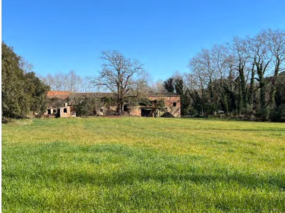
Estat actual vista des del sud. Font: Pròpia.
