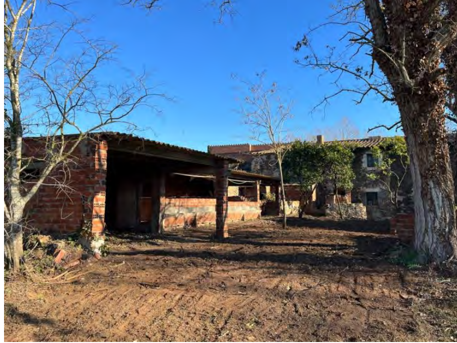
Construccions de totxana i coberta de plaques de fibrociment per a l'establació de bestiar amb poc interès arquitectònic o patrimonial. Font: Pròpia.
