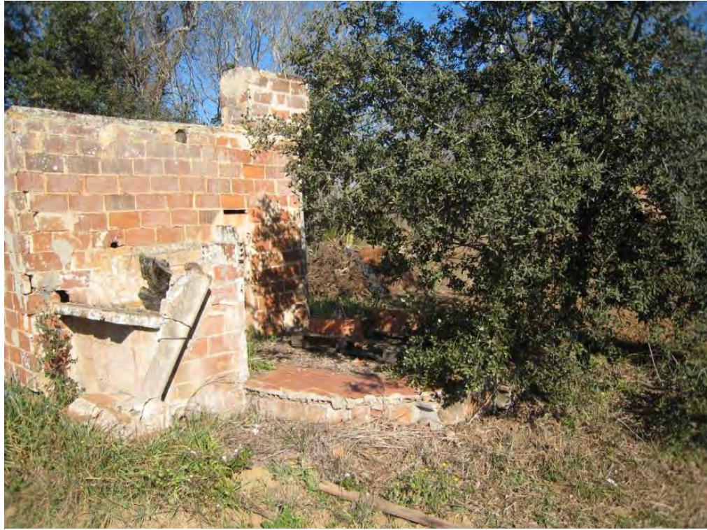
Caseta del pou proper a la masia. Font: pròpia.
