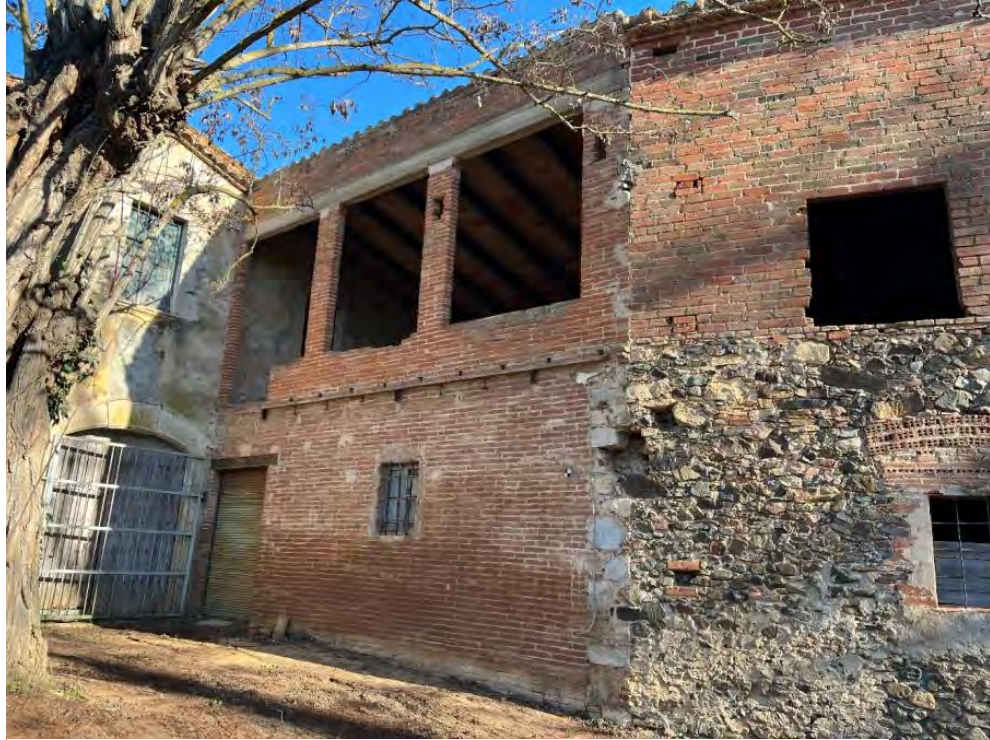
Façana sud-oest magatzem. Font: pròpia.
