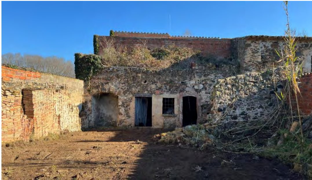
Façana principal, sud-est, masia Can Fidel. Font: pròpia.
