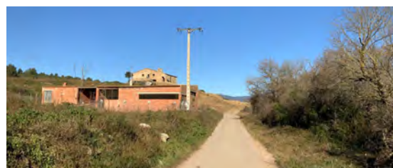
Vista de l'àmbit 7 des de l'extrem sud-est
