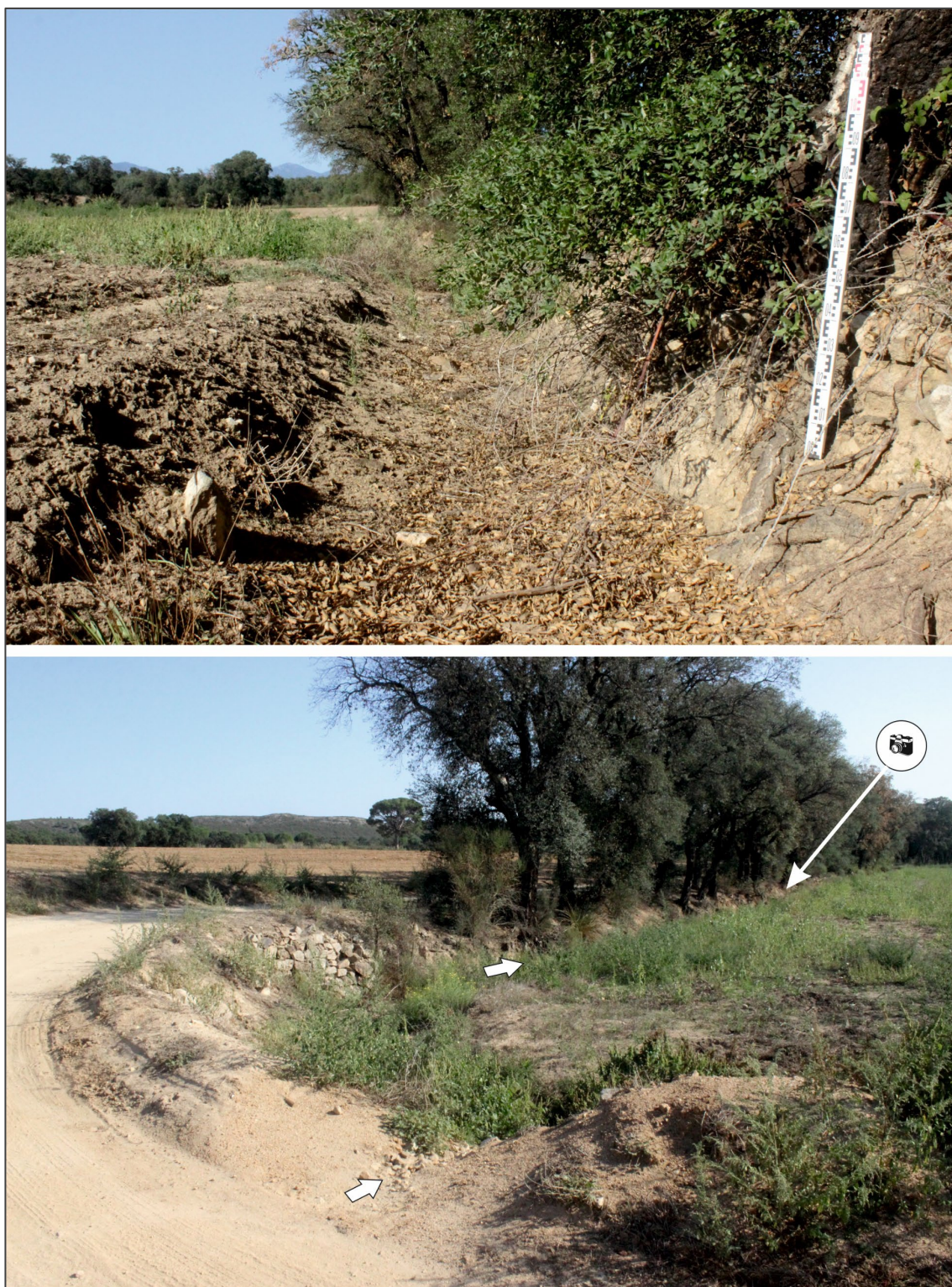
Figura 24 Vista de la secció de la cuneta de drenatge. El punt de la foto apareix a la imatge inferior.
