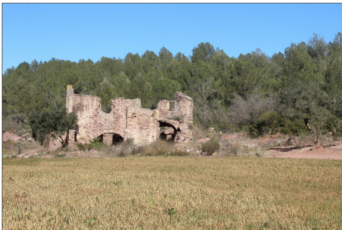
Figura 11 Vista de les ruïnes de Mas Oriol, a l'àmbit 6.
