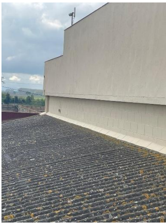
Imatges del perímetre de la coberta:
