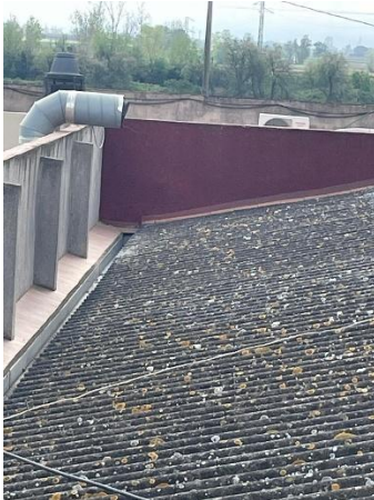
Imatges de l'aiguafont de la coberta:
