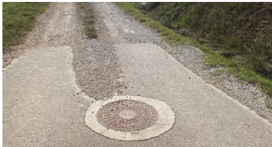
Fotografia 1. Vista general de la captació.
