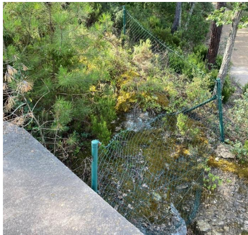
Fotografia 10. Tancament perimetral del dipòsit de Juià.
