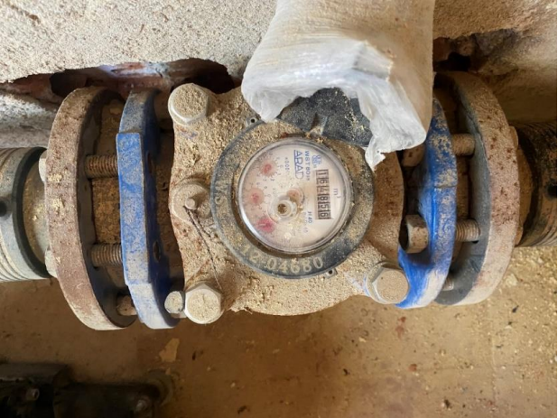
Fotografia 5. Vista detall del comptador del Dipòsit de Juià.
