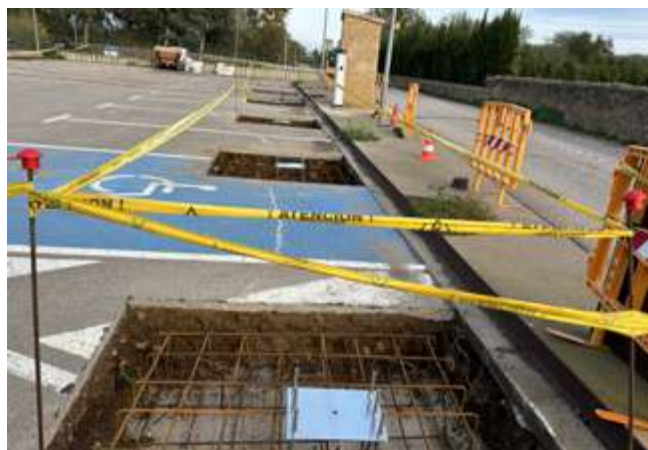
Començament de les obres
