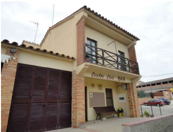
Foto nº 2: Façana accés porxat
