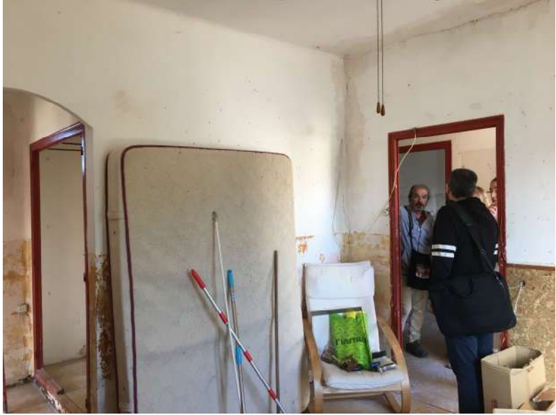
Foto nº 4: Interior de la Sala d'estar existent, vista cap al passadís d'entrada
