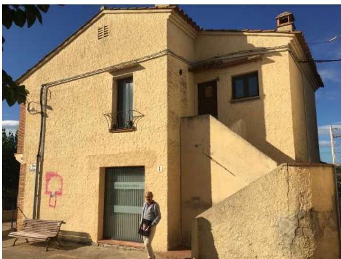
Foto nº 3: Façana Est, escala d'accés
