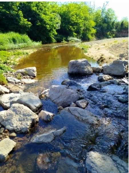
Rocs i trossos de formigó aigües avall de la passera.
