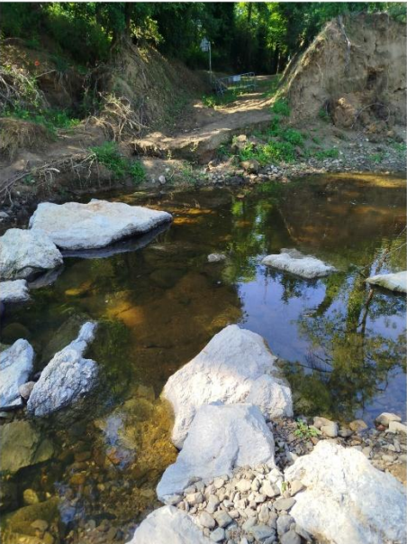
Camí per creuar el riu en mal estat i no accessible.
