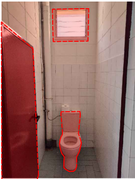
20. RETIRADA DE 2 WC 21. RETIRADA DE 2 PORTES 22. RETIRADA DE 2 FINESTRES
