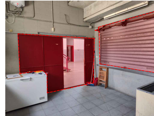
6. RETIRADA DE PORTA D'ENTRADA 7. RETIRADA DE PERSIANES D'ALUMINI
