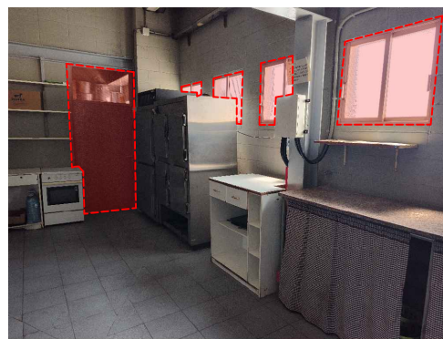
3. RETIRADA DE FINESTRES 4. RETIRADA DE PORTA
