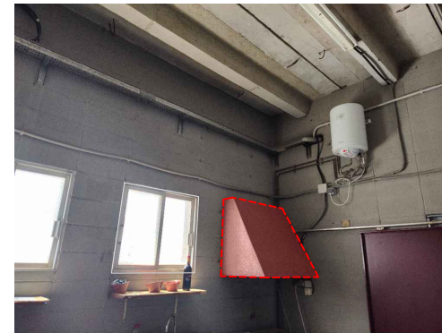
5. RETIRADA DE CAMPANA EXTRACTORA
