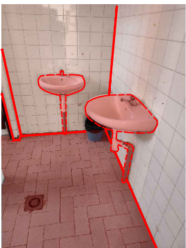
23. RETIRADA DE 2 PIQUES 24. RETIRADA DE DISPENSADORS DE PAPER I SABÓ 25. RETIRADA DE TUBERIES 26. ENDERROC CERÀMICA 27. ENDERROC PAVIMENT
