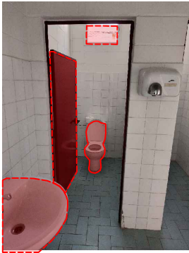
7. RETIRADA DE 2 PIQUES 8. RETIRADA DE 2 WC 9. RETIRADA DE 2 PORTES 10. RETIRADA DE 2 FINESTRES
