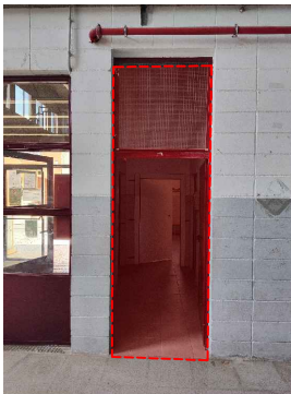
18. RETIRADA PORTA ENTRADA VESTIDOR 1
