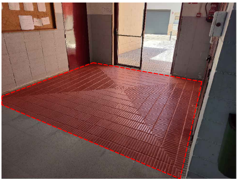
32. ENDERROC DE PAVIMENT VESTÍBUL
