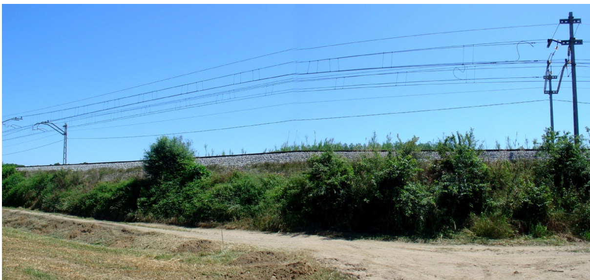
Marge de poc de més de 2 metres i pendent 3H:2V a l'entorn de la via del tren
