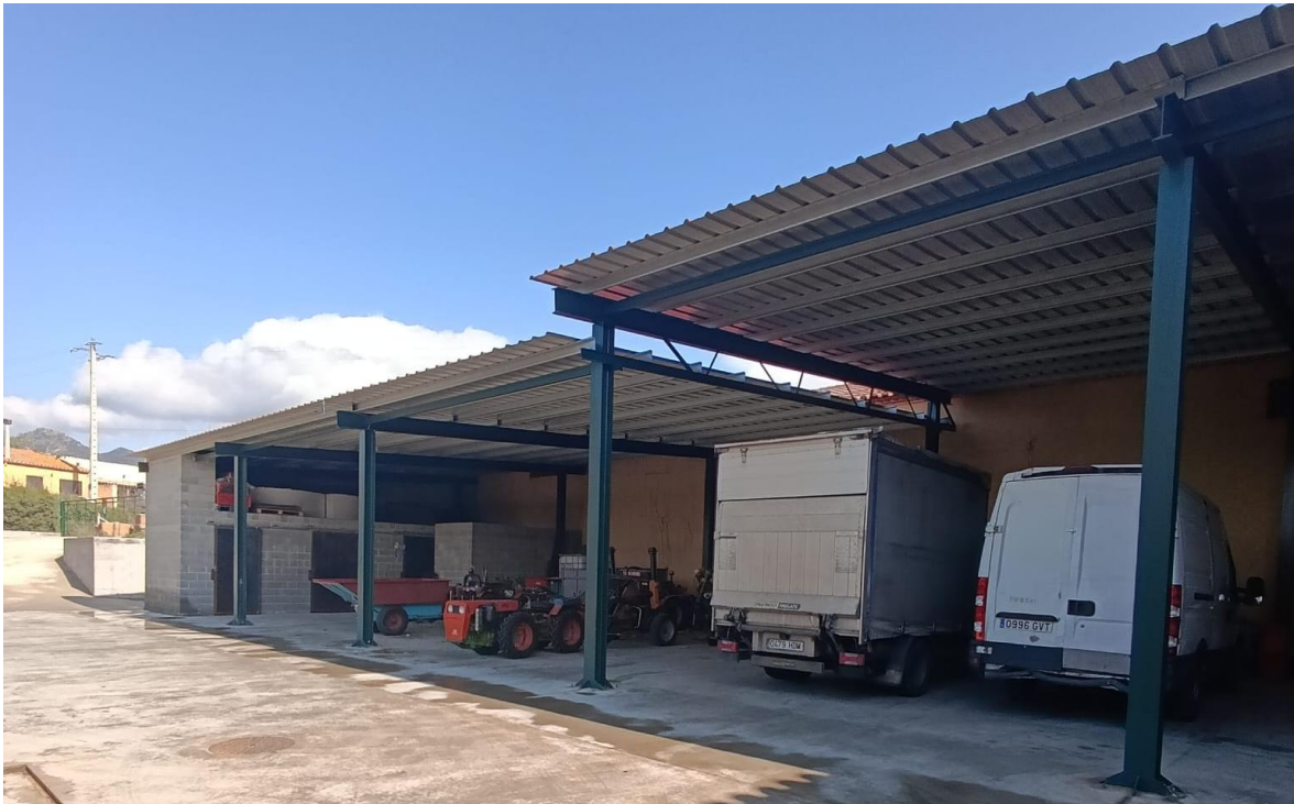
Il·lustració 4. Coberta destinada a la instal·lació fotovoltaica
