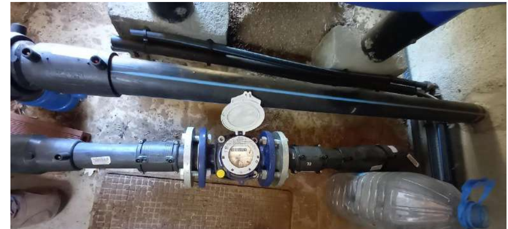
Figura 5 – Cabalímetre de mesura d'aigua procedent del pantà d'Espolla, situat a l'entrada del dipòsit.
