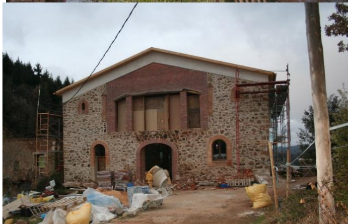
Fotos 2012 reparació de coberta i part de la façana enderrocada
