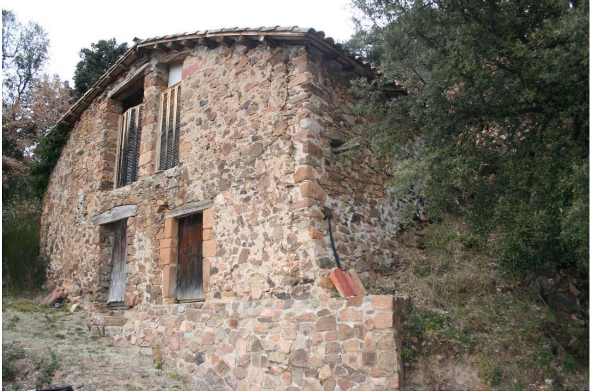
Pallisa , edificació auxiliar
