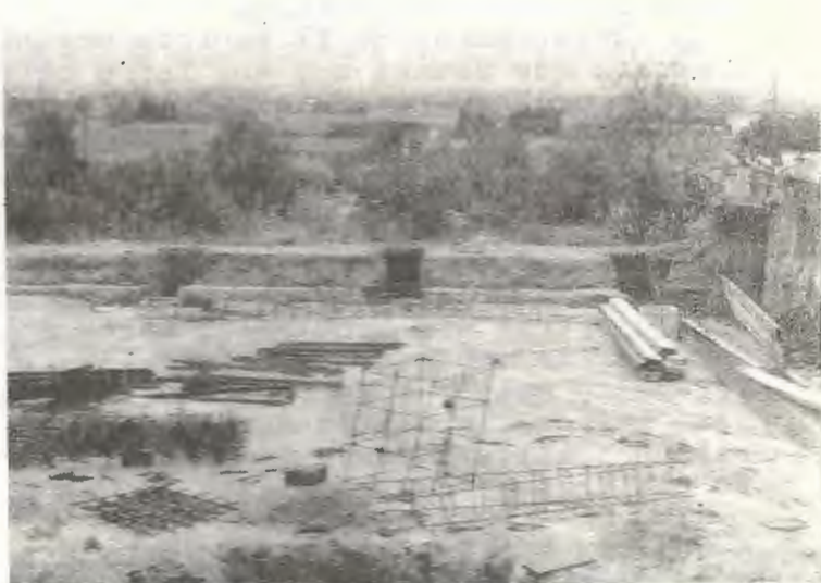
Estat de les obres de construcció del Centre Cívic.
