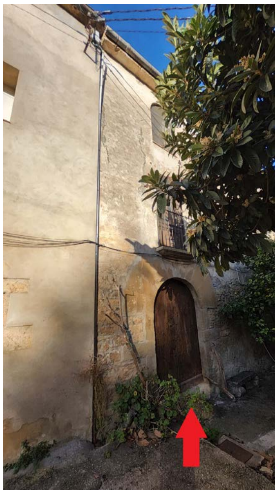
Façana est – Entrada a la Central (Les Serres)
