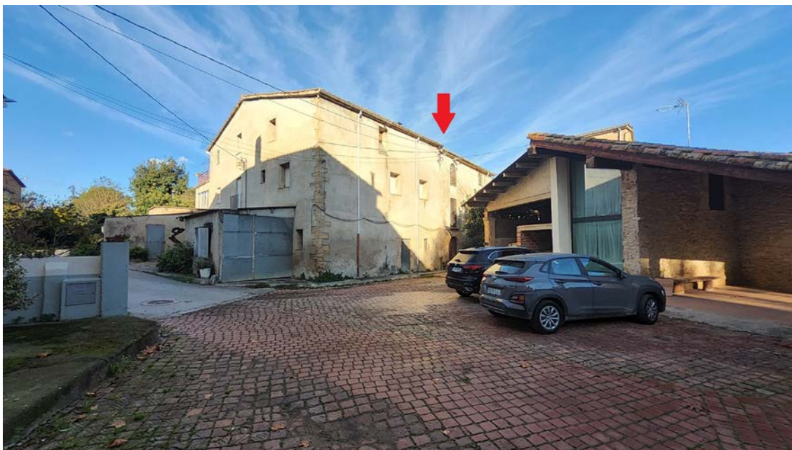
Façana est – Detall on es produeix el canvi de coberta entre els dos habitatges.
