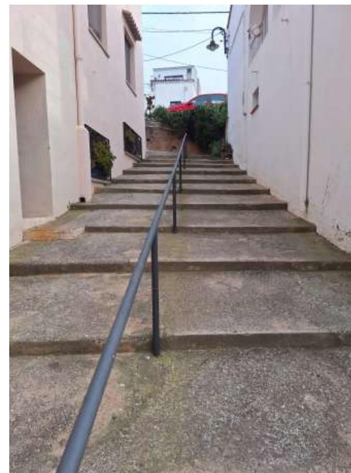
Escala existent de connexió entre C/Labrun i C/ del Mar
