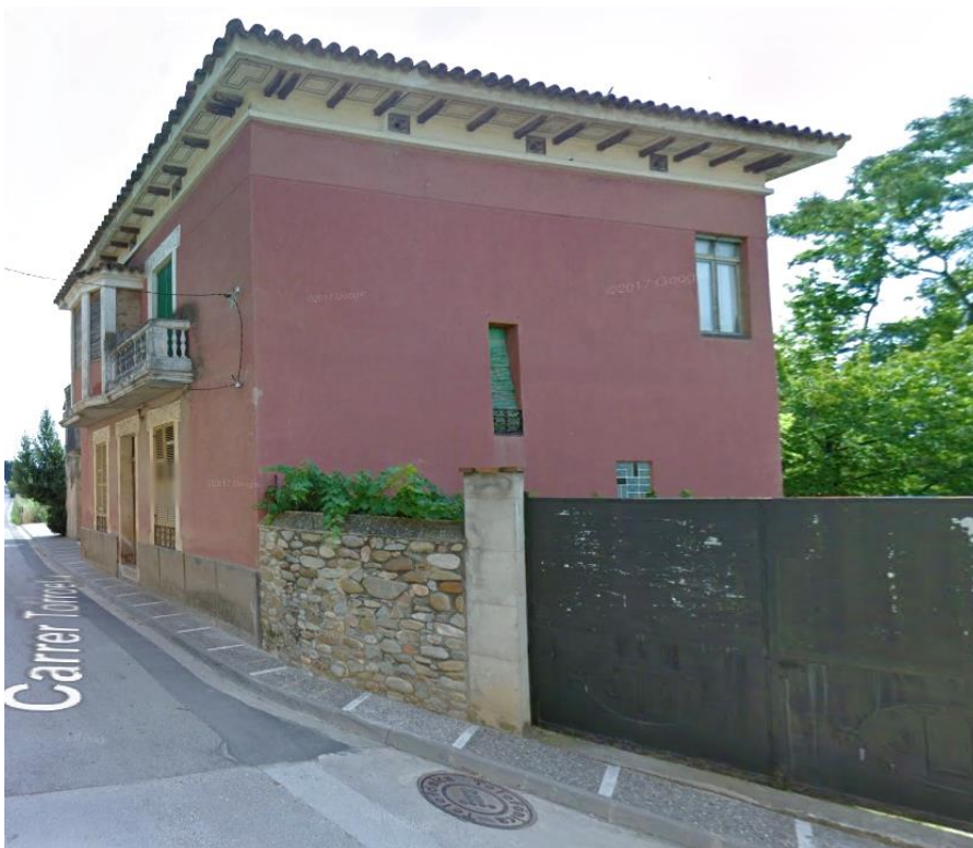
Casa d'estil modernista al carrer Torroella. A nord de l'illa 17.
