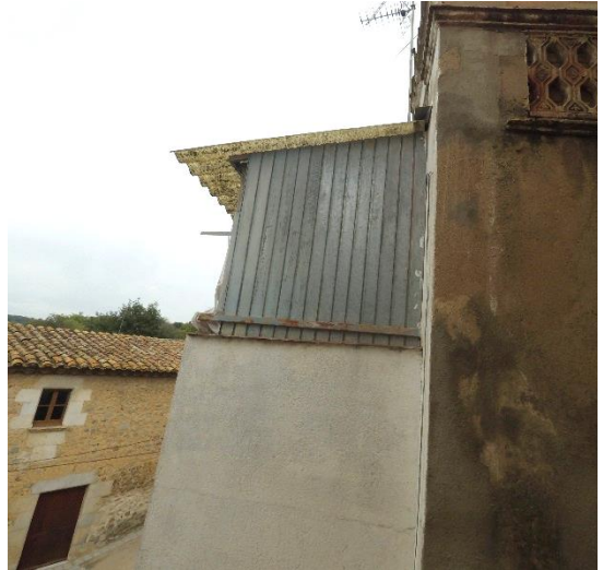
Lateral dret, on s'observa com s'adossa el cos en la façana original.
