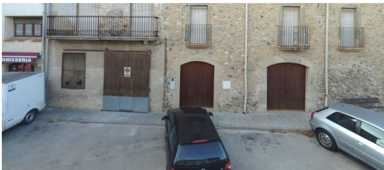
Espai de vorera que el POUM qualifica com a Sistema d'espais lliures.
