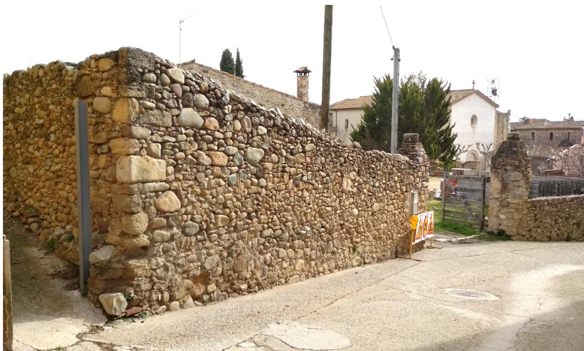
Portal d'accés a l'espai on es preveu el nou sostre en clau Em3. La tanca de pedra coincideix amb el possible nou creixement.
