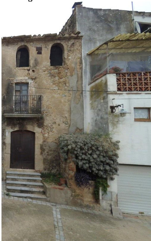
Lateral esquerre, on s'aprecia com s'ha recrescut el cos aprofitant l'existència del pou de la finca veïna.
