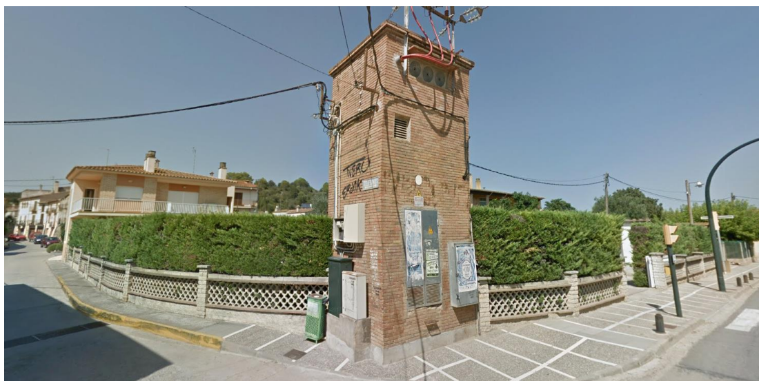
Fronts oest i sud de l'illa 15. Intersecció del carrer Torrent amb l'Avinguda Catalunya.
