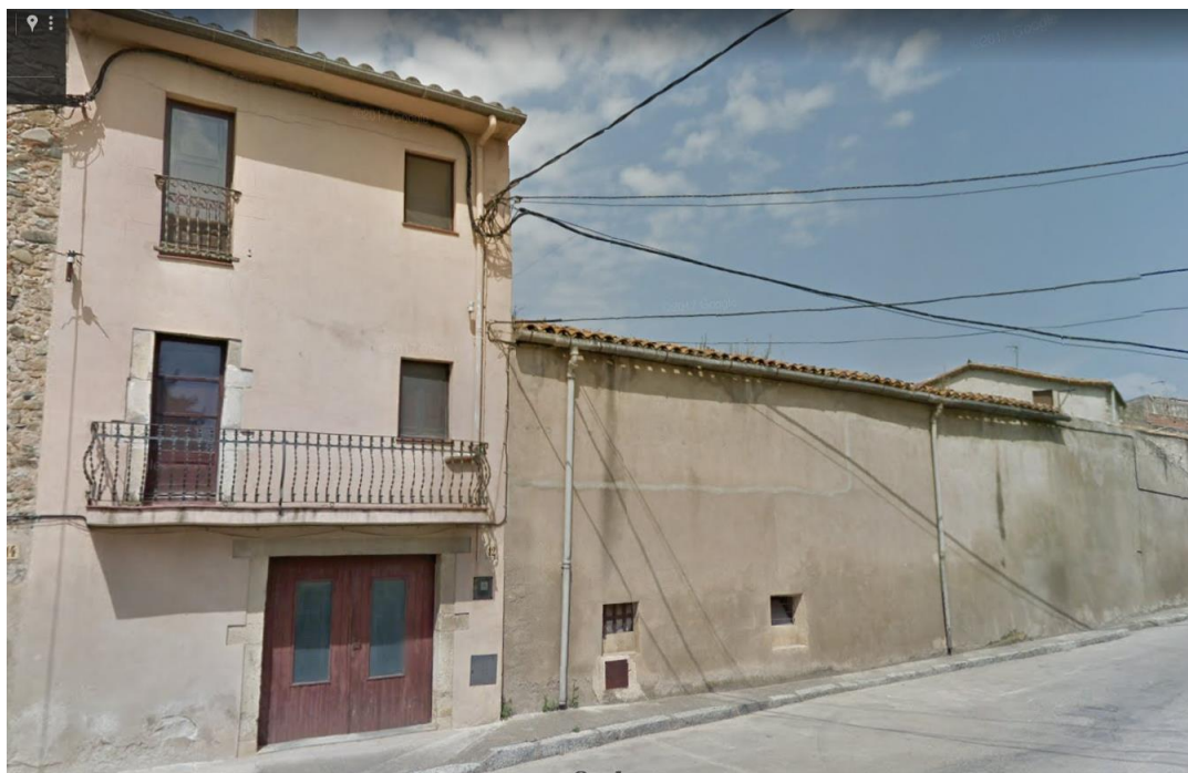
Façana de la finca 12-14, al carrer Torrent, en el tram on es preveu l'obertura del nou vial.
