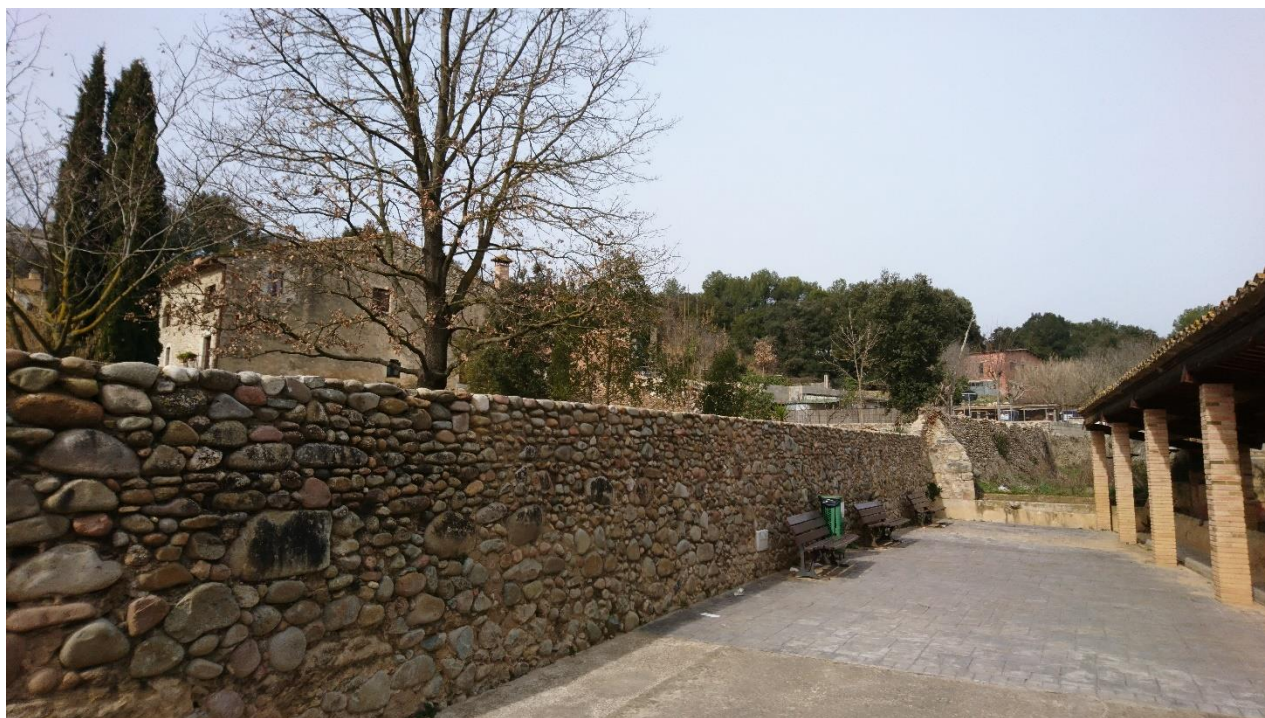
Tanca de pedra de la finca de Can Fill de Déu en l'àmbit que delimita la superfície en clau Em3. A la dreta, l'espai públic del safareig.
