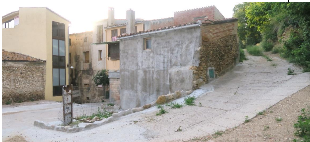
Contigu a la façana de ciment pòrtland, s'ubica l'àmbit 10.
