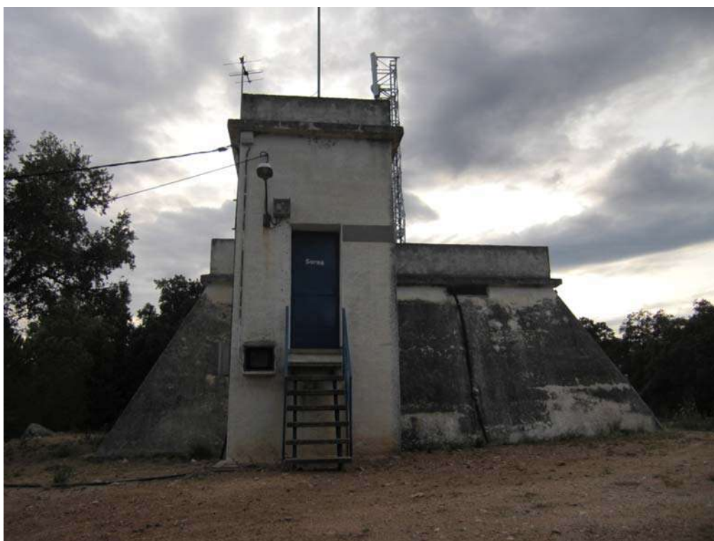
Foto núm. 5 – Vista del dipòsit de Capmany amb la caseta en primer terme.
