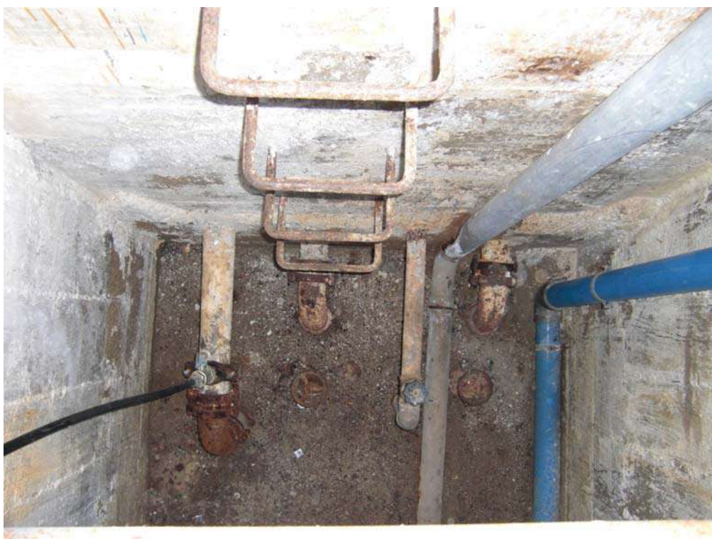
Foto núm. 8 – Vista interior de l'arqueta de claus del dipòsit.
