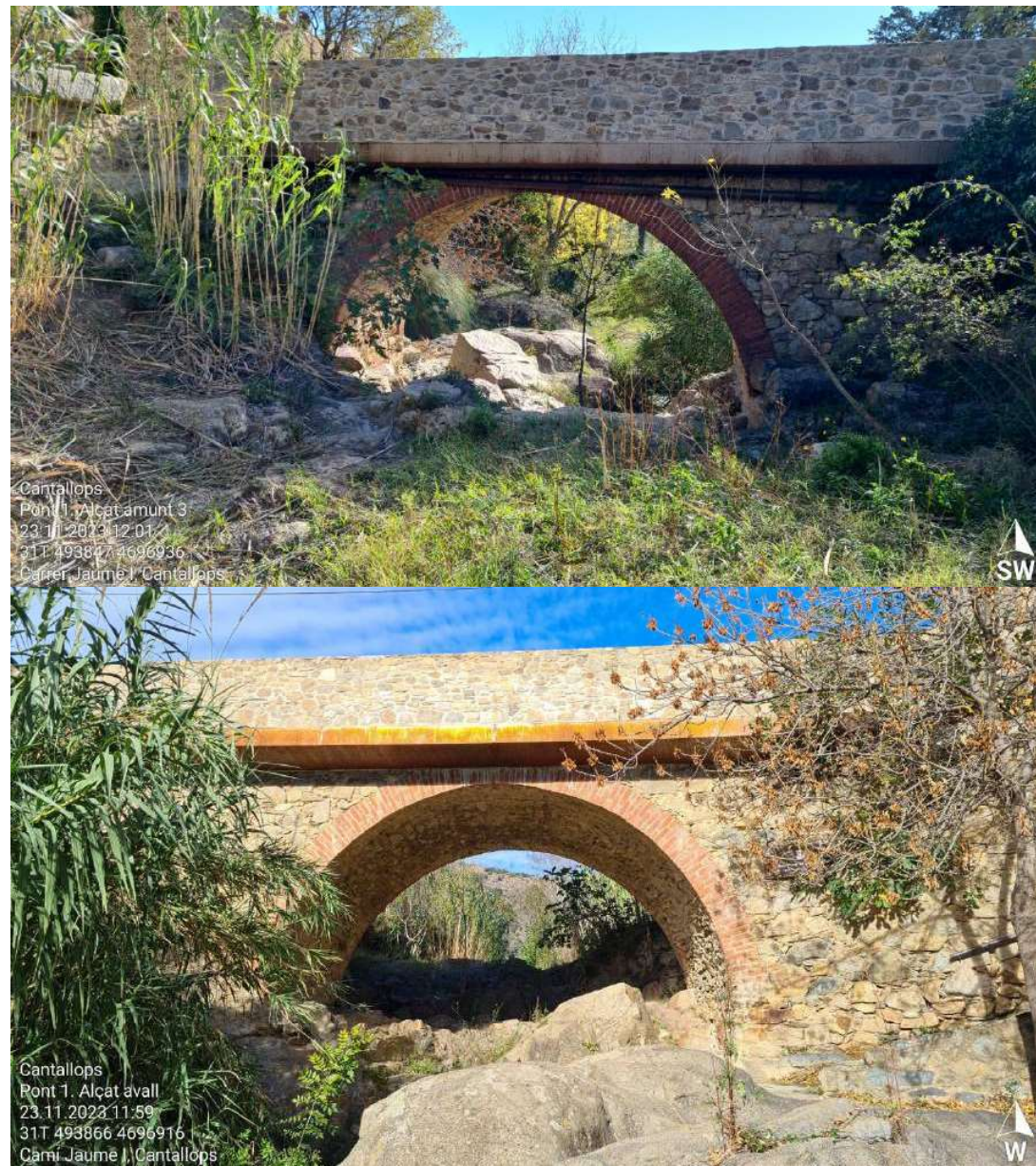
Alçats aigües amunt i avall del pont Sobrepera
