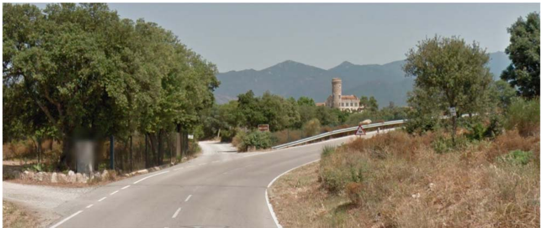
Confluència de tres camins. A l'esquerra, camí al Mas de la Pena (Campmany); al centre, continuació del camí de Sant Climent a Bell-lloc; a la dreta, tram de vial executat per a l'enllaç amb el camí de Cantallops a Sant Climent Sescebes. Al fons, el mas de Bell-lloc.
