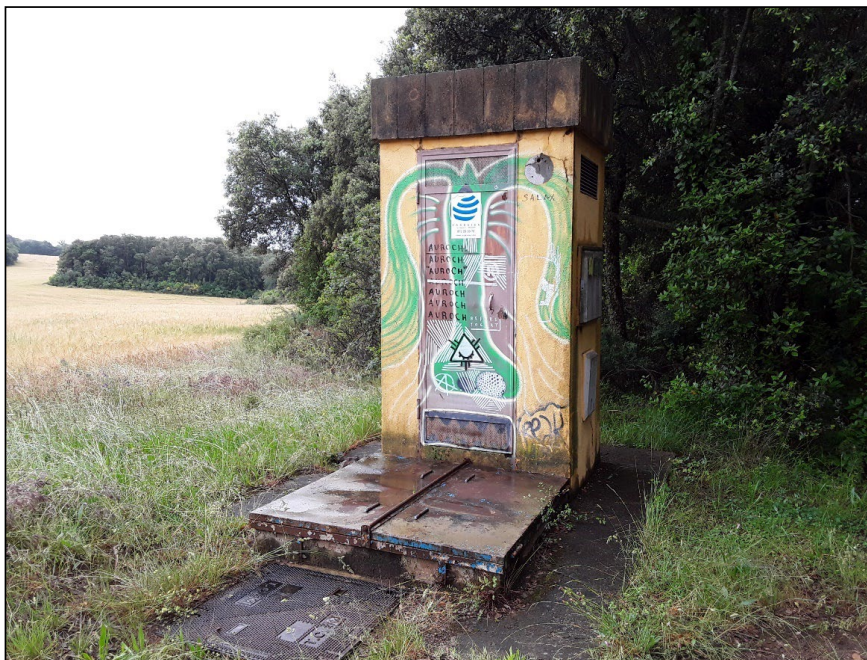
Imatge 3. Vista general de la captació del Pou Vell
