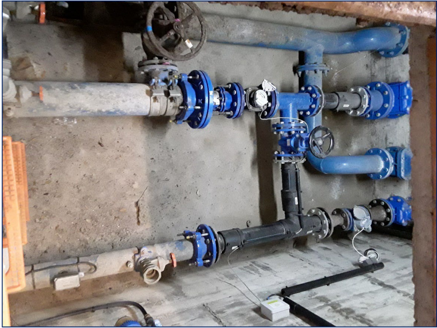
Imatge 7. Canonades d'entrada i sortida, desguàs, sobreixidor i vàlvules i comptadors corresponents
